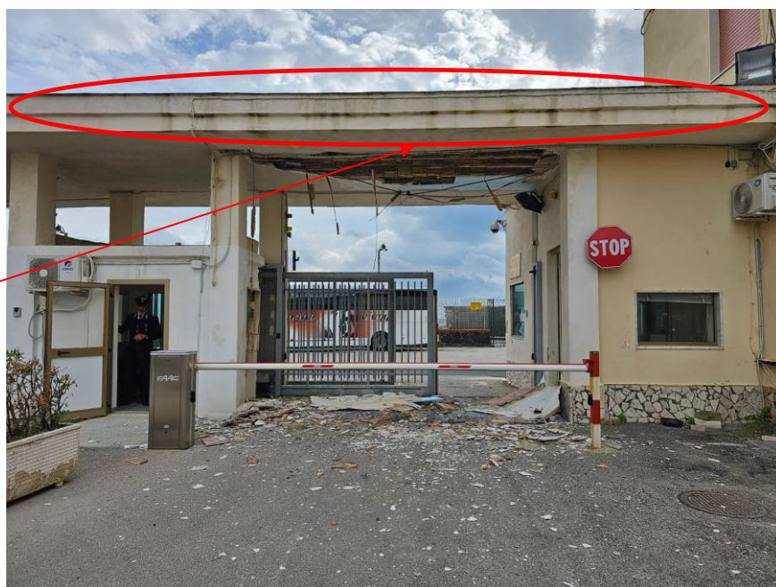
Figura 3 – particolare frontalino solaio di copertura varco d'accesso
