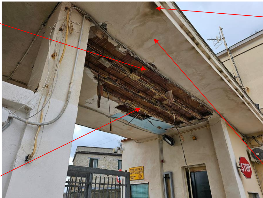
Figura 2 – intradosso solaio di copertura varco d'accesso al sedime di Nisida (NA) – stato ante intervento di messa in sicurezza
