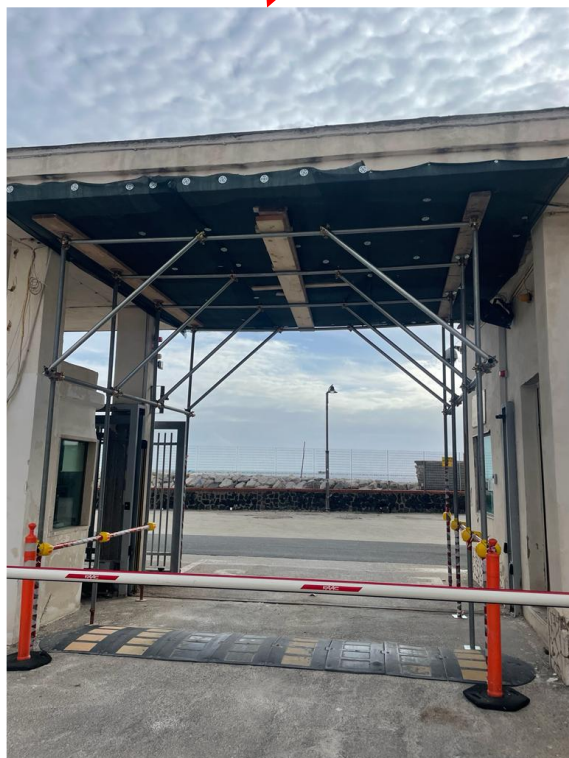
Figure 4, 5, 6 – intradosso solaio di copertura varco d'accesso al sedime di Nisida (NA) – stato post intervento di messa in sicurezza
